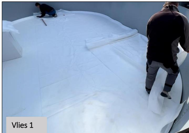
Achten Sie darauf, dass Sie die Bahnen ca. 20 cm überlappen. Schneiden Sie das Vlies entlang der Rundung mit etwas Übermaß ca. 5 cm und schieben Sie das übermäßig Vlies dann hinter die Keile. (Siehe Bilder Vlies 2 + Vlies 3)
