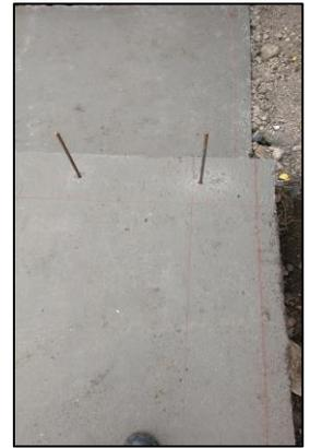
Wenn die Fundamentplatte Ihres Pools begehbar ist, wird mit der Herstellung der Beckenwände begonnen. Legen Sie nun das Beckeninnenmaß genau fest und zeichnen diese mit Hilfe einer Schlagschnur an. Die Poolsteine werden nun entlang dieser Schnur gleichmäßig aufgesetzt, dabei ist zu beachten, dass die Seite mit den Federn nach oben zeigt. Bei der Ecke sind die Steine im 90° zu versetzen und stumpf zusammenstoßen – die Feder an der Schmalseite ist dabei zu entfernen.
